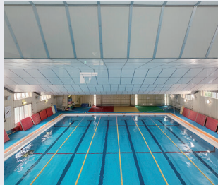
プール天井材
