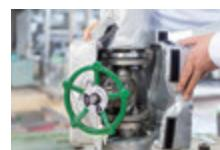
バルブやガスケット交換などでも、保温カバーの着脱が必要な場合に、誰でも作業できるようになればという提案を受け開発された「カガサモジャケット(KTJ)」。**フルオーダーメイドで作られかつ軽量**なので、女性でも着脱が簡単。**埃もほ**
