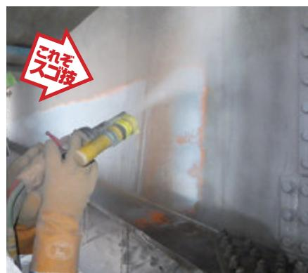
塗装業界で注目を浴びる新工法「ダブルプラスチ工法」は、有害物質を含む既存塗膜を完全に除去したのち、素地調整程度1種を成形する工法。ウェットプラスチで湿润させた後に有害物質を1回で完全に除去し、オープンプラスチで湿式によるプラスチを実施した際に発生する戻り錆を除去する。
