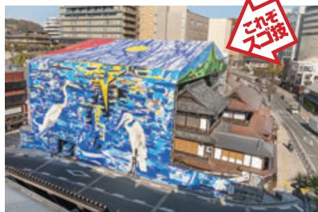
大型インクジェットプリンターと大型膜体加工工場を自社にて保有しており、道後温泉本館を覆う「道後ラッピングアート」を製作(膜の印刷・設計縫製加工)。最新のインクジェットと独自の膜加工技術により紙を破った紙繊維の断面や筆のハケ跡、重ねられた色の奥行等、細部に至るまで原画の質感を再現。
