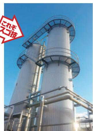
嫌気性微生物を使用した排水処理装置「SUPER Depcer」は、従来処理が困難だった**高濃度排水を省エネルギー・省コスト・省スペースで可能にする**、**処理過程で得られるメタンガスを自家発電の燃料として利用できること**などから燃料コストが削減でき、従来の排水処理法よりも余剰汚泥が大幅に減量、機器動力も約1/10程度となっている。
