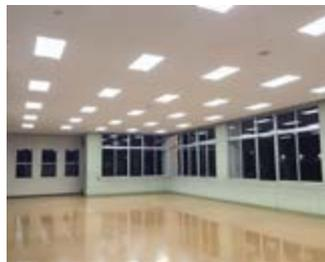
LEDパネルライトは、従来の天井吊り下げ式でなく、埋め込み式のフラットパネル型。液晶テレビのバックライト技術を活用することで、薄型・軽量化を実現。一般的な埋め込み型の照明の重さが5kgから7kgほどあるのに対して、このLEDパネルライトの重さは約2.7kg。これも、天井用化粧石膏ボードとほぼ同じ重さ。またサイズも同じため、工期・工費も大幅に削減できる。また軽い照明は、地震など有事の際の落下を防ぐことにもつながると期待されている。
