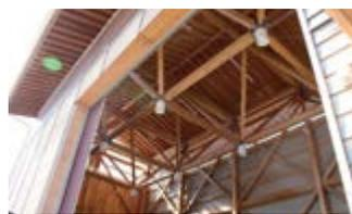
木材の小口からクロスピンハンガーを通し、専用のドリフトピンを刺してエポキシ樹脂で固定。耐久性能が高く、表から見える金具の少ない木材の美しさを活かした仕口とし、大断面の柱・梁に使用する「クロスピンハンガーシステム工法」(特許取得済)は、体育館や大型ホールなどの大空間に用いることができる。
