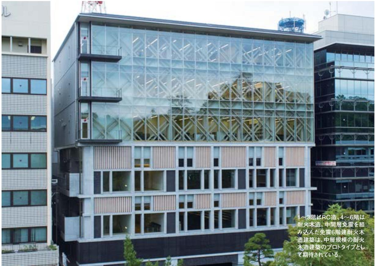
1～3階はRC造、4～6階は耐火木造。中間層免震を組み込んだ免震6階建耐火木造建築は、中層規模の耐火木造建築のプロトタイプとして期待されている。
