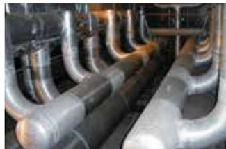
長年、ガスメーカー向け設備で提供してきたアルミ配管技術を近年更に強化し、溶接技術の向上を推し進めてきた。アルミ配管製作専用の工場も設備、小径管から800Aの大径管まで対応可能。難しいとされる現地でのアルミ配管の組立とTIG溶接（RT対応）も長年の実績を持っている。また近年ではJISのみではなく船級の溶接資格も取得。LNGタンカー向けの配管製作にも対応し実績を増やしている。
